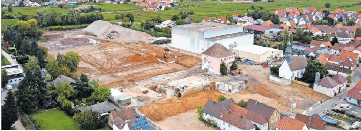
Zehn bis zwölf Monate sind für die Erschließungsarbeiten auf dem ehemaligen Sektellerei-Gelände vorgesehen.
