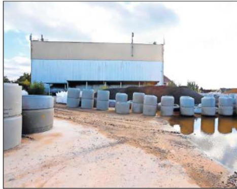
Die Halle auf dem Nachbargrundstück wird abgerissen.
